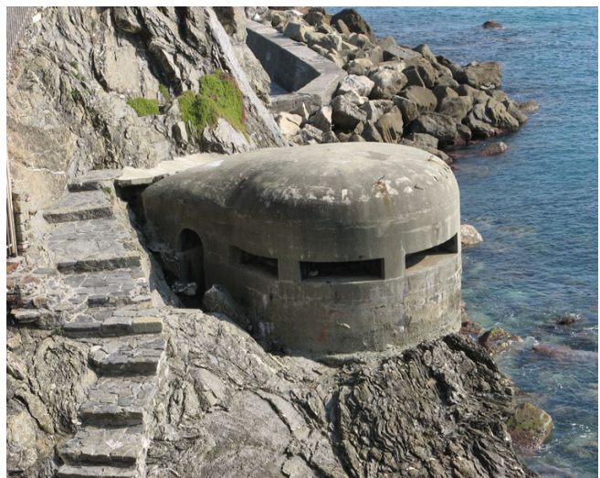
Fig.2 = Bunker del Vallo Alpino.
